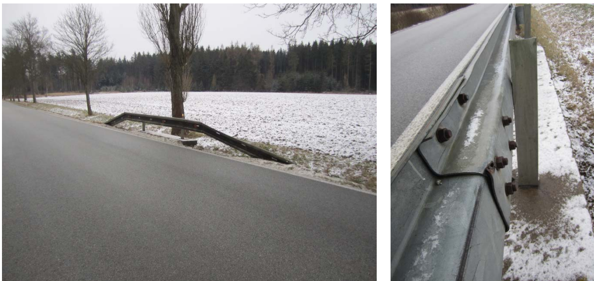
Obrázek 9: Délka a chybějící prvky záchytného systému v km 19,15.
