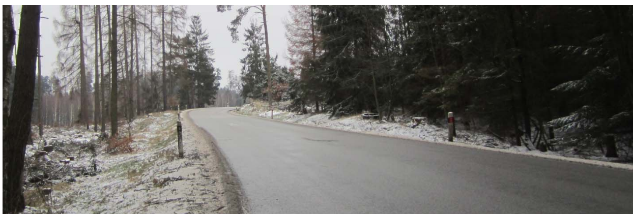
Obrázek 12: Směrové oblouky s nedostatečnými rozhledovými poměry (obrázky shora dolů – km 19,72 po směru staničení, km 19,89 proti směru staničení, km 20,01 – po směru staničení).
