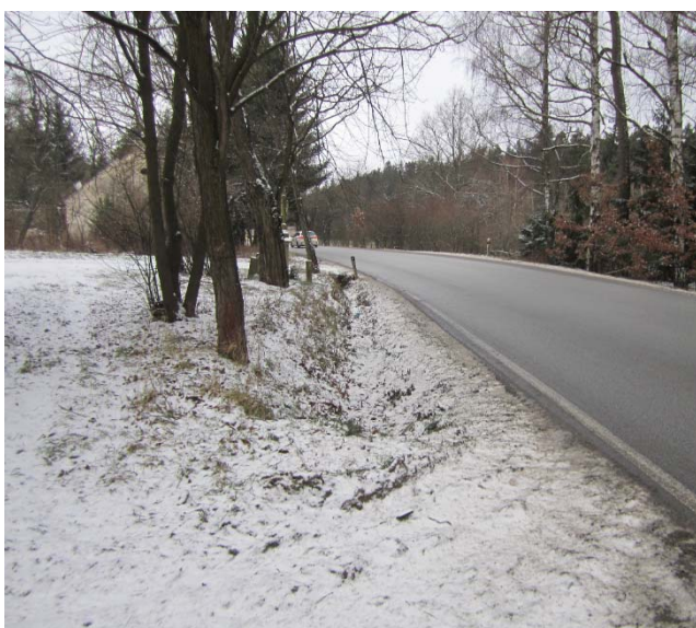
Obrázek 11: Nedostatečné rozhledy z napojení na komunikaci II. třídy (obrázek nahoře vlevo v km 19,67 – rozhled vpravo, obrázek nahoře vpravo v km 19,73 – rozhled vlevo, obrázek dole v km 19,75 – rozhled vlevo).
