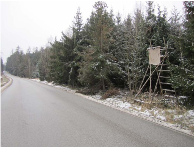
Obrázek 7: Příklad míst s nedostatečnou vzdáleností stromů od kraje vozovky.
