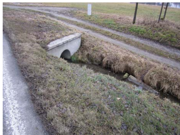
Obrázek 3: Místa s nedostatečnou nebo žádnou ochranou odvodňovacího zařízení či pevné překážky.
