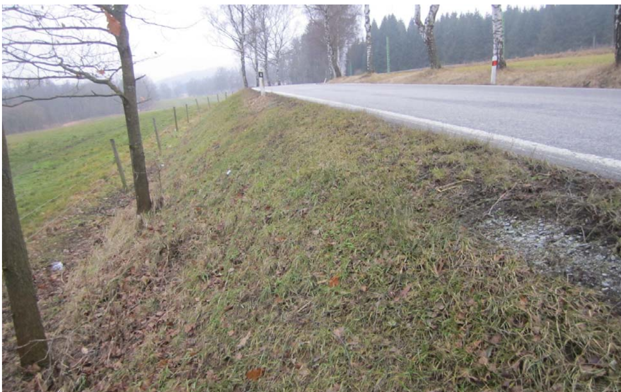
Obrázek 8: Svah ve směrovém oblouku v Km 38,4 – pohled proti směru staničení.
