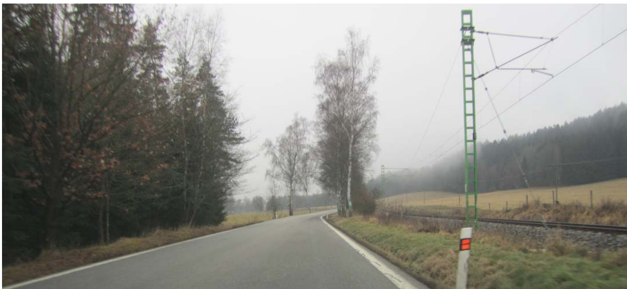
Obrázek 7: Místa blízkého souběhu silnice a železnice.
