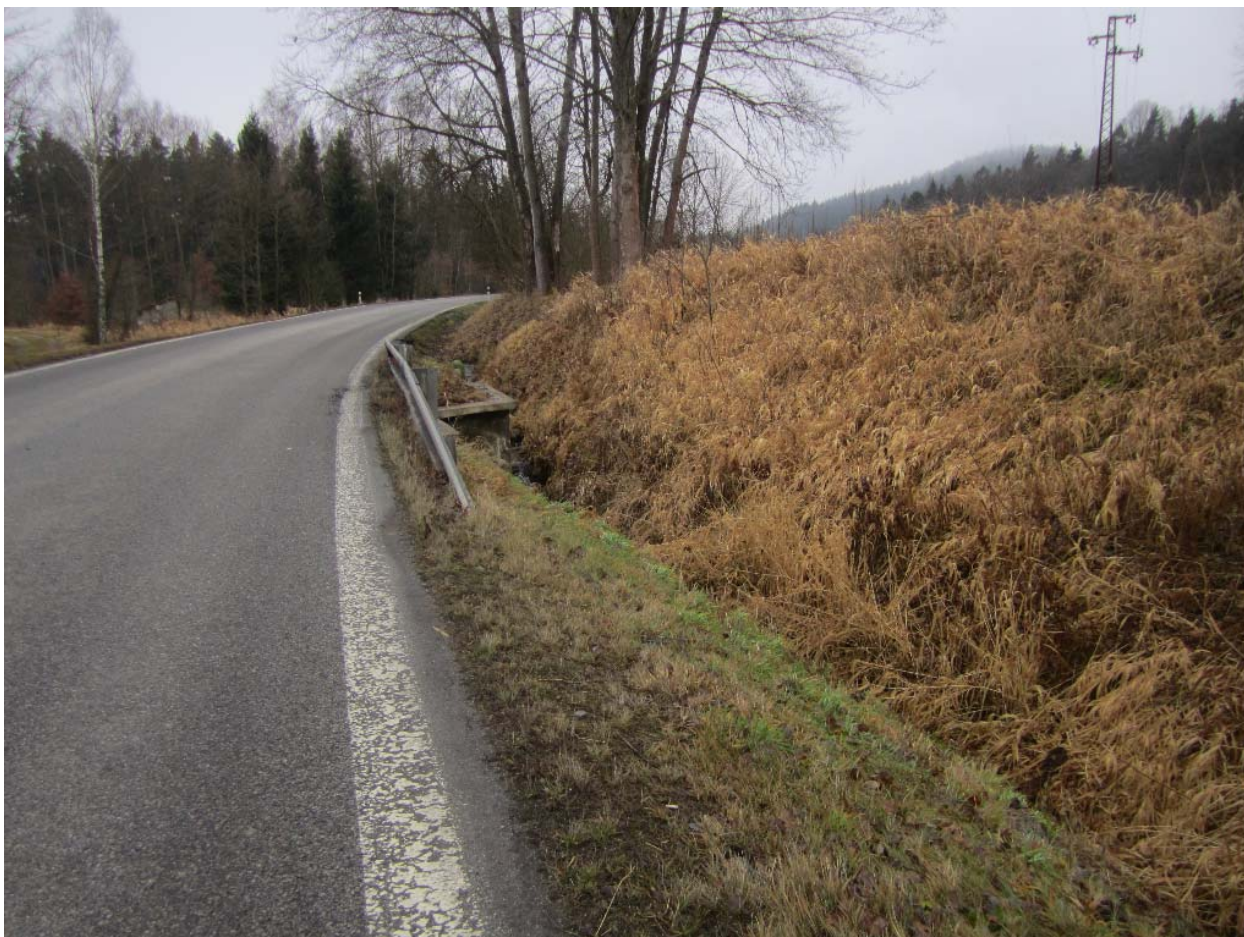
Obrázek 10: Nedostatečné směrové poměry, pohled proti směru staničení.
