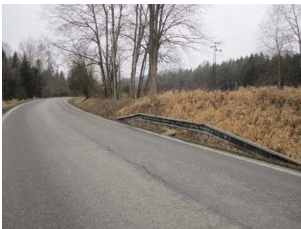
Obrázek 3: Místa s nedostatečnou nebo žádnou ochranou odvodňovacího zařízení či pevné překážky.
