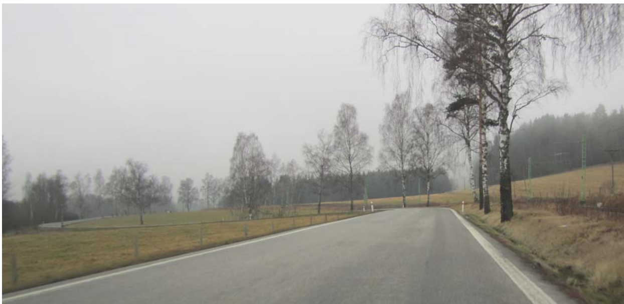
Obrázek 9: Nevýrazné vedení komunikace – proti směru staničení.
