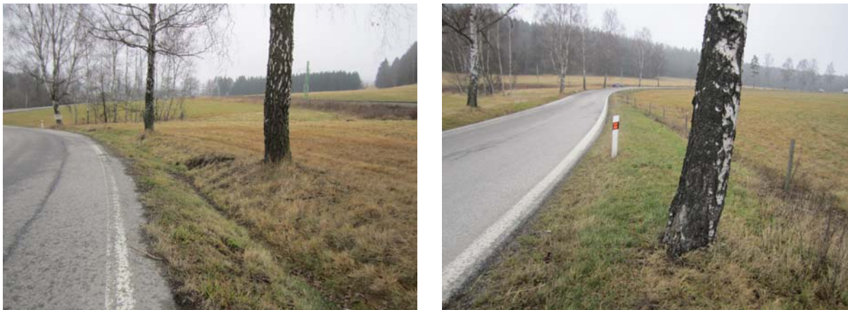
Obrázek 4: Ukázka vzdálenosti pevných překážek na úseku.
