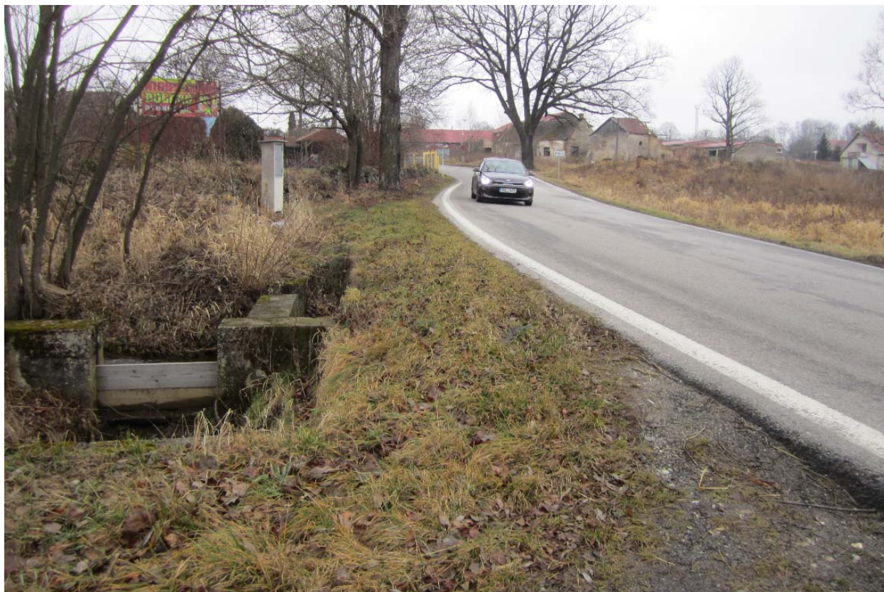
Obrázek 11: Masivní pevná překážka v blízkosti komunikace.
