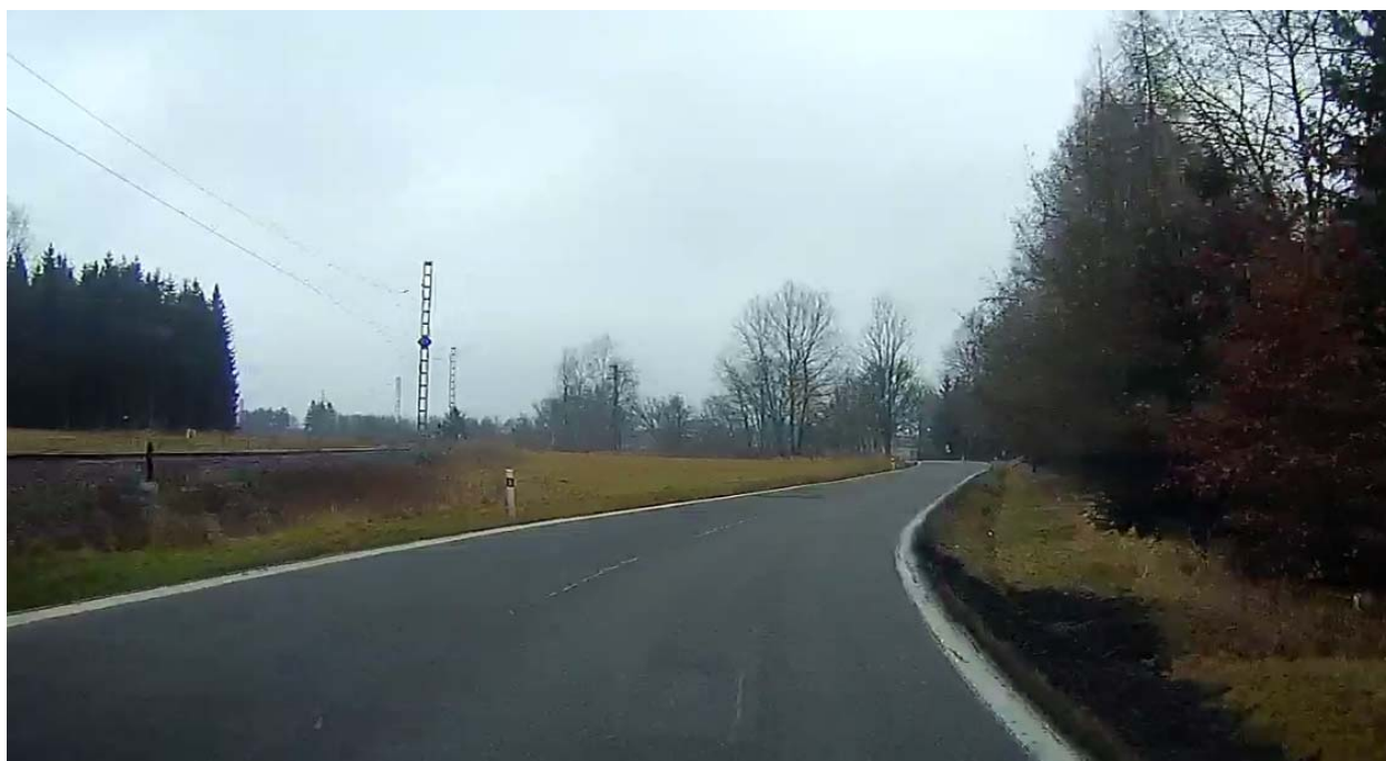
Obrázek 5: Chybějící sloupky zhoršují vedení především za snížené viditelnosti..
