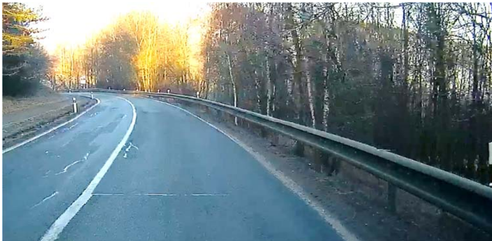
Obrázek 7: Pohled proti směru staničení – sloupky svodidla jsou zakotveny na hraně svahu
