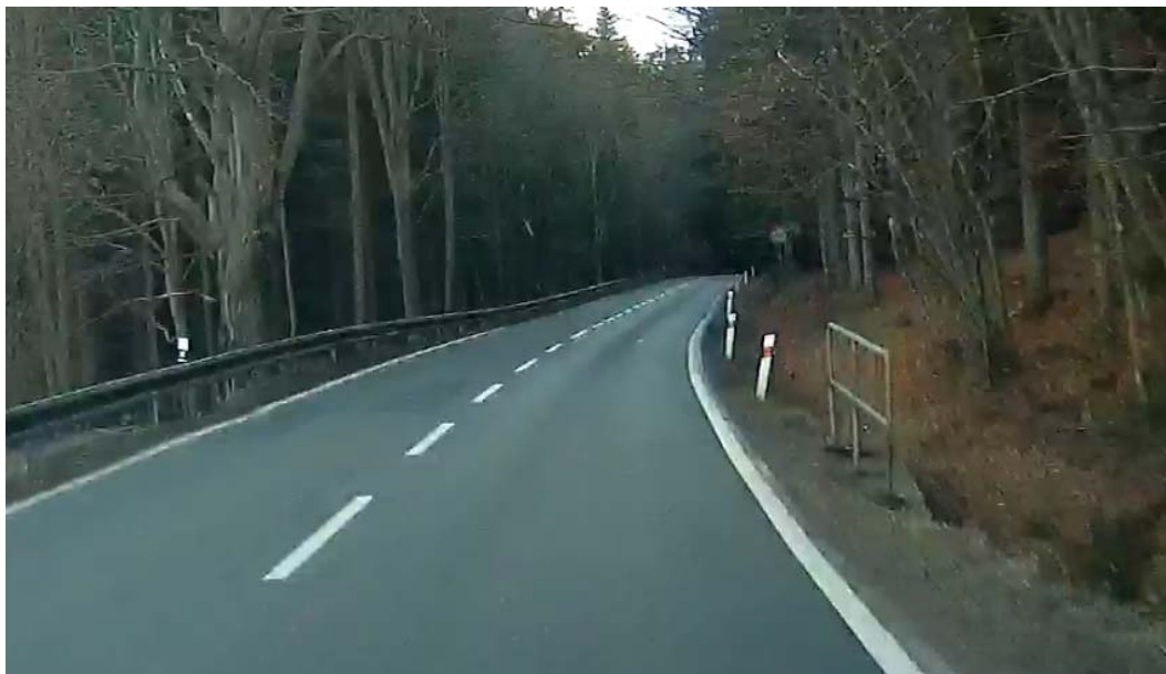
Obrázek 3: Pohled proti směru staničení na kolmé čelo propustku.
