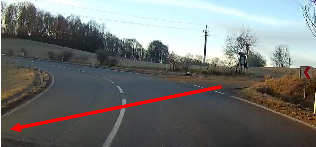
Obrázek 6: Pohled po směru staničení v místě křižovatky s místní komunikací do Perlovic (červeně vyznačeno možné přetékání vody přes sil. II/141).
