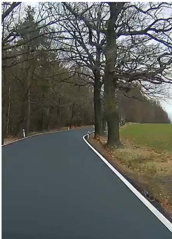
Obrázek 3: Nedostatečný rozhled pro zastavení ve směrovém oblouku (vlevo km 45,45, vpravo km 46,41).
