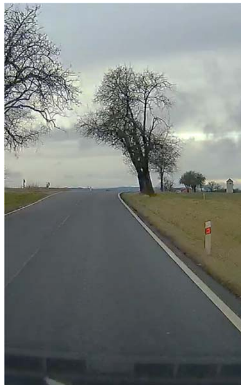
Obrázek 3: Nedostatečný rozhled pro zastavení ve směrovém oblouku (vlevo km 45,45, vpravo km 46,41).
