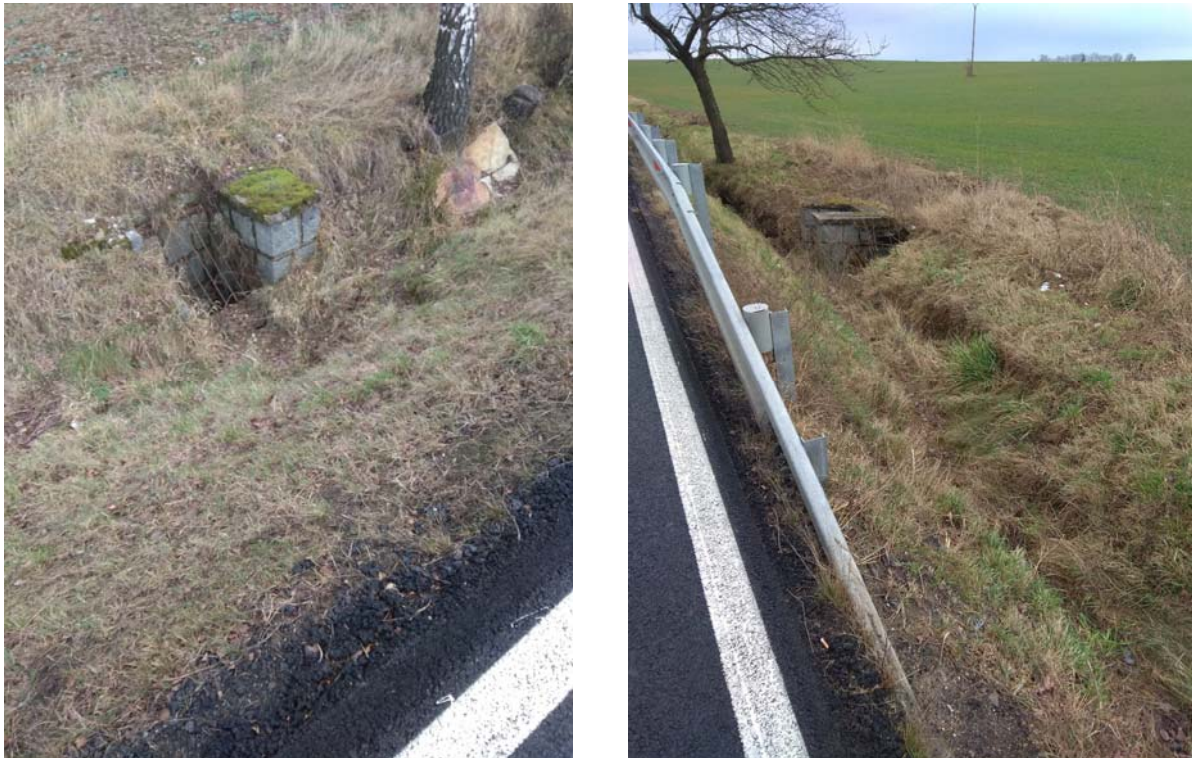
Obrázek 4: Horská vpust v km 45,94 vpravo a vlevo.
