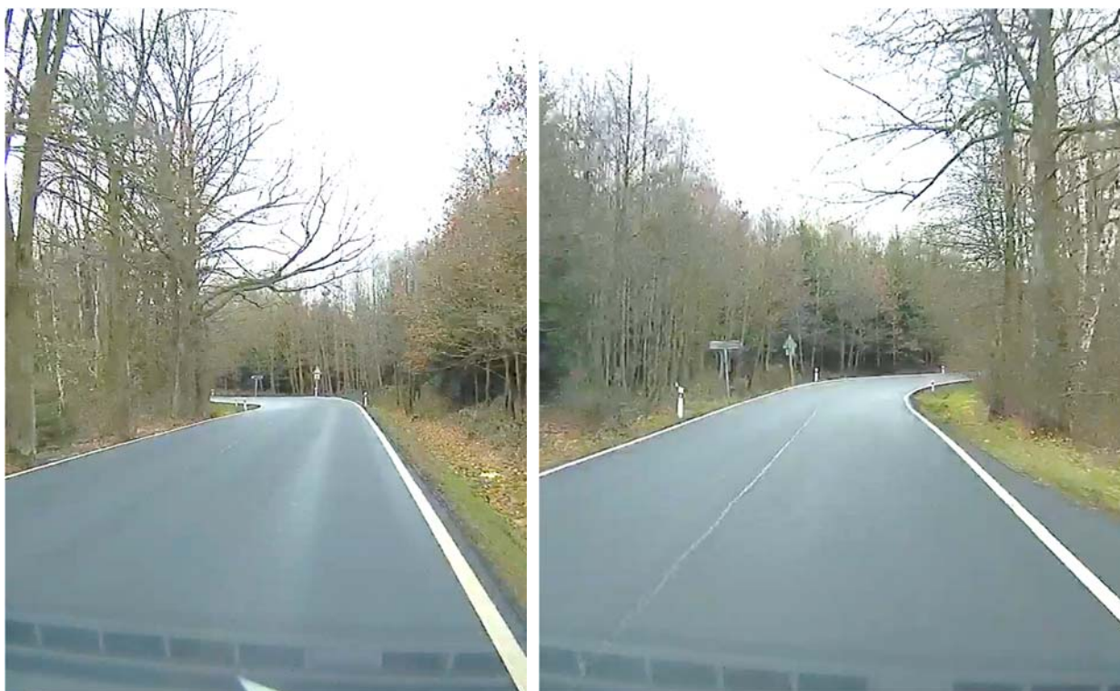
Obrázek 10: Vlevo pohled na směrový oblouk po směru staničení (směr Srubec) / vpravo proti směru staničení (směr Ledenice). Nedostatečný rozhled ve směrovém oblouku – stromy u vnitřní strany oblouku.
