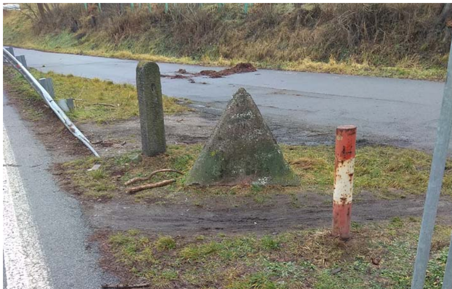
Obrázek 5: Zábrana proti přeježdění vlevo tvoří pevnou překážku.
