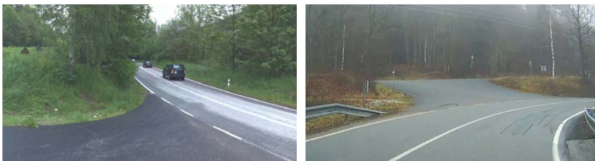
Obrázek 10: Vlevo - pohled vlevo z místa sjezdu – zeleň v místě rozhledu, vpravo pohled na sjezd proti směru staničení II/141.
