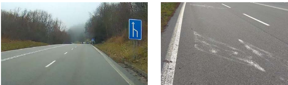
Obrázek 4: Vlevo - DZ č. IS 12b a výhled řidiče na další vedení komunikace. Vpravo – opotřebované VDZ.
