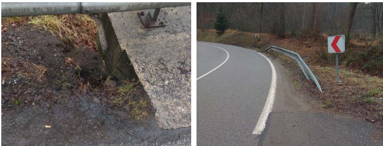
Obrázek 12: Vlevo ujíždějící svah na výtoku z propustky, vpravo krátké svodidlo.
