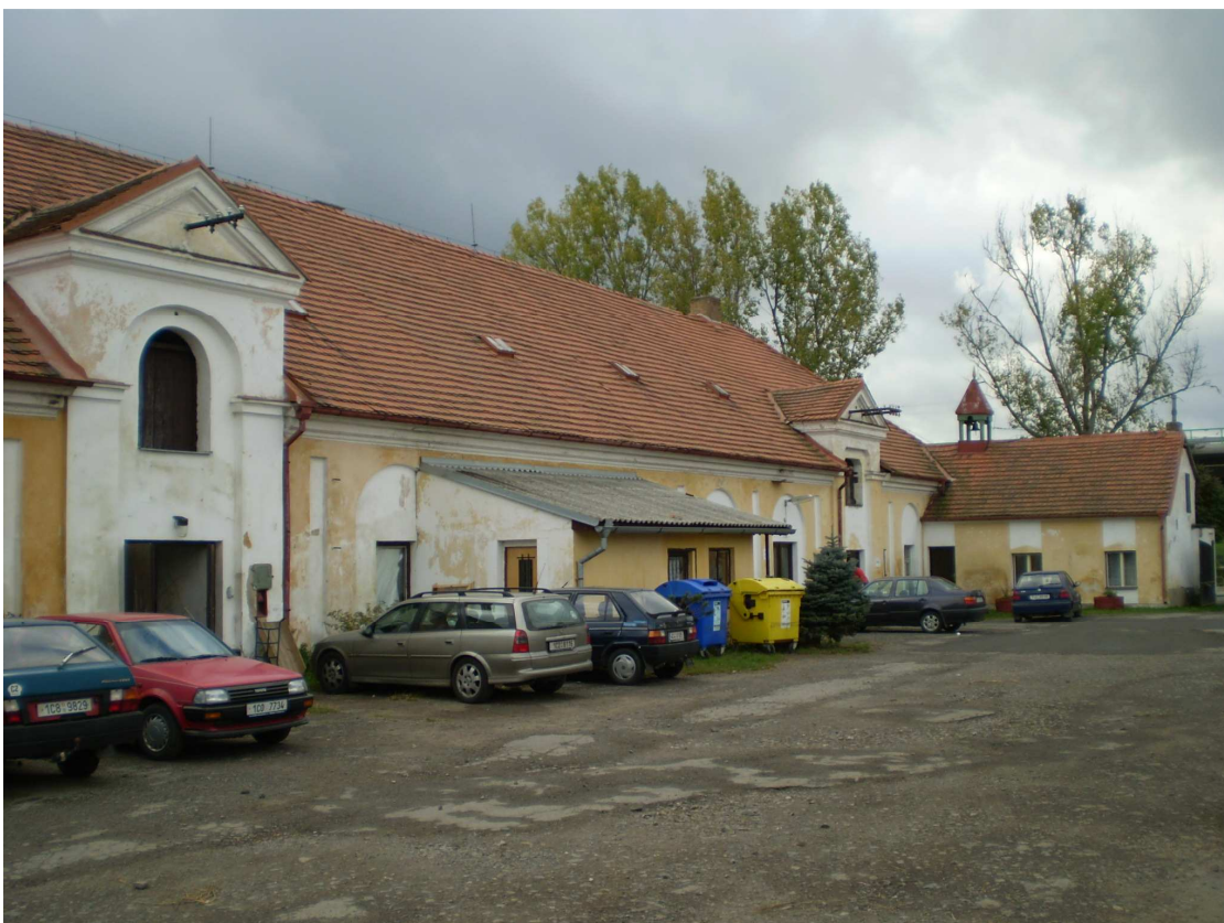
Pohled na nemovitosti v k. ú. Písek – mléčnici na st. p. č. 2745/3 s budovou na st. p. č.2745/5, ke které byla v r. 1970 přistavěna
