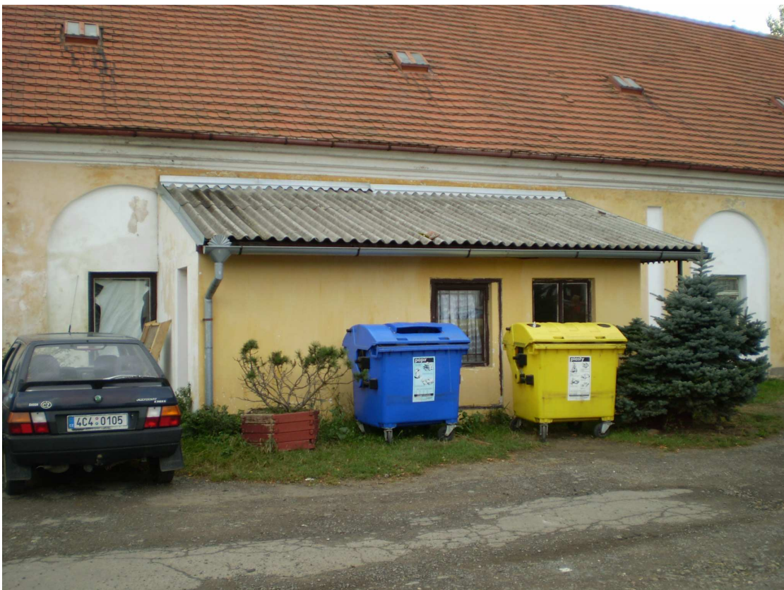
Budova mléčnice na st. p. č. 2745/3 v k. ú. Písek navržená k demolici
