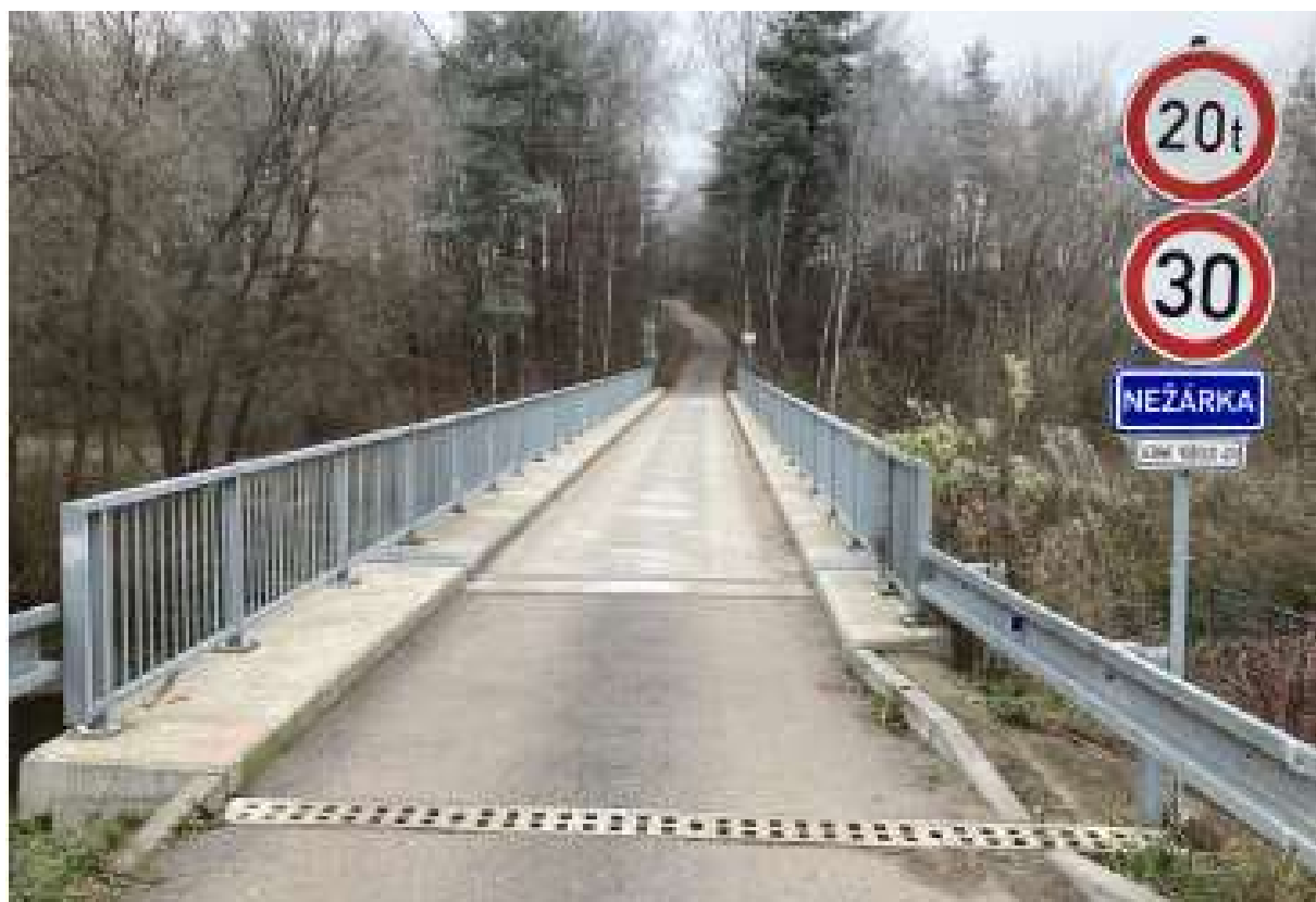
Most na místní komunikaci – směr na obec Dvorce
