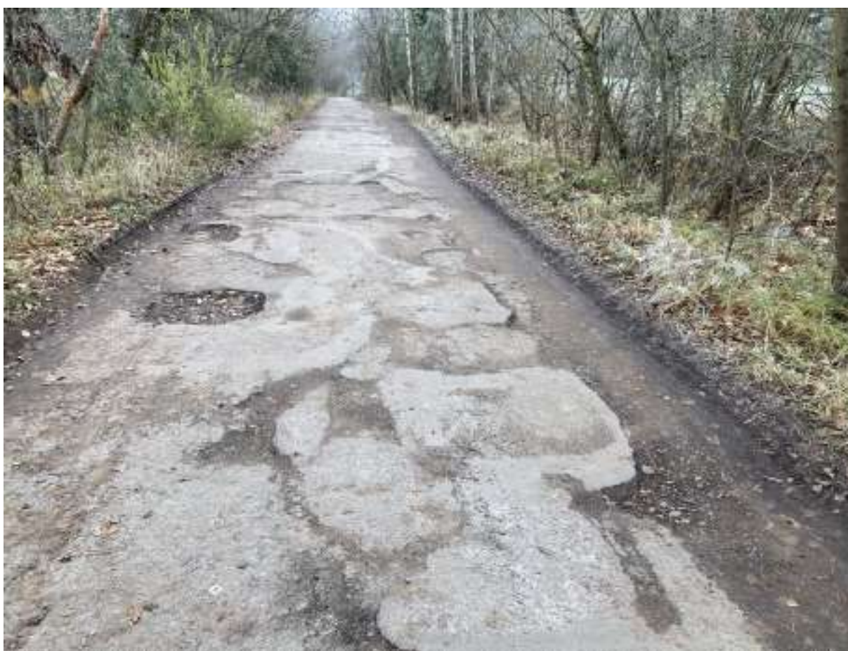
Místní komunikace 5c – Dolní Lhota
