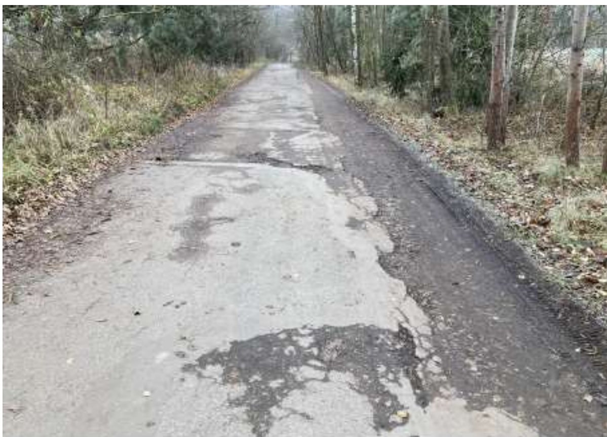
Místní komunikace 5c – Dolní Lhota
