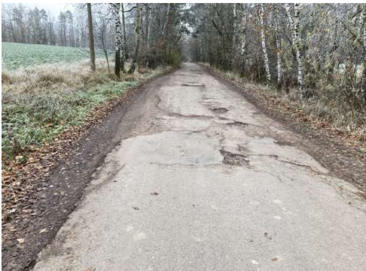
Místní komunikace 5c – Dolní Lhota
