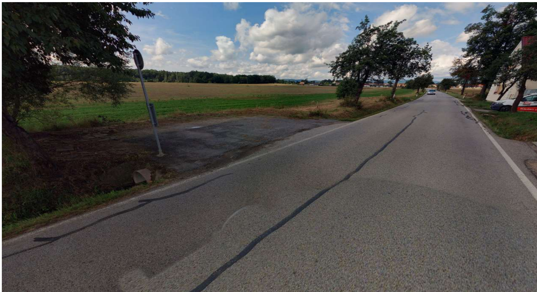
část p. č. 874 - (součást(zastávky autobusu))
